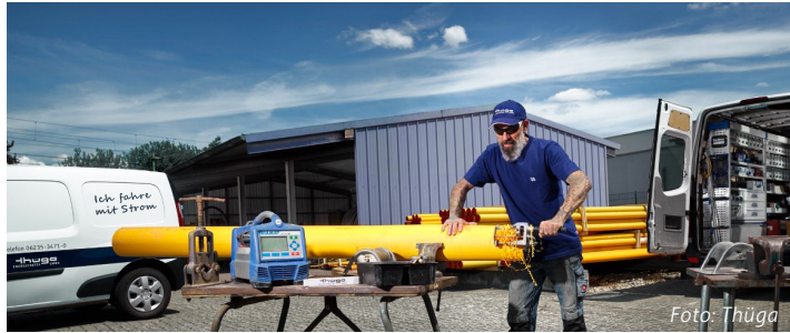
Vorbereitungsarbeiten für die künftige Versorgung mit Wasserstoff.
