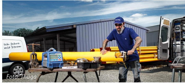
Vorbereitungsarbeiten für die künftige Wasserstoffversorgung.
