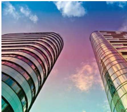
DGNB-Zertifizierung für Neubau von Stützle
